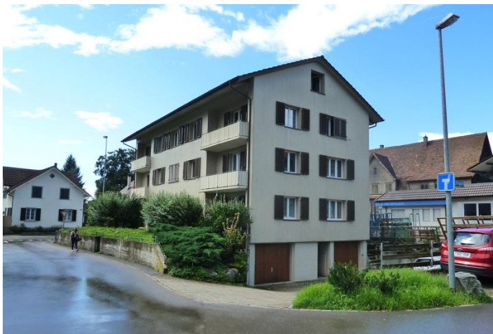
Mehrfamilienhaus mit sechs Einheiten in Bettwiesen TG
