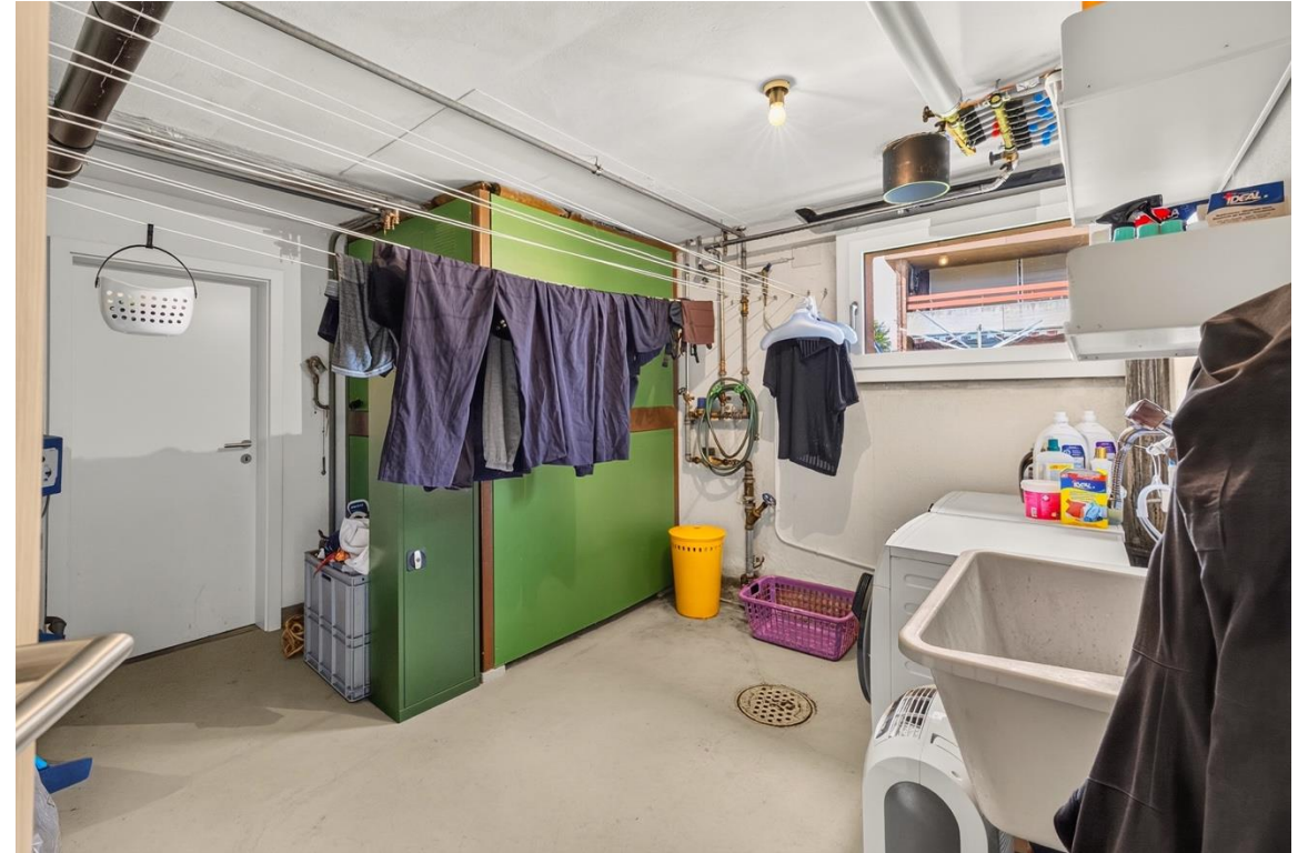
Technik- und Waschraum
